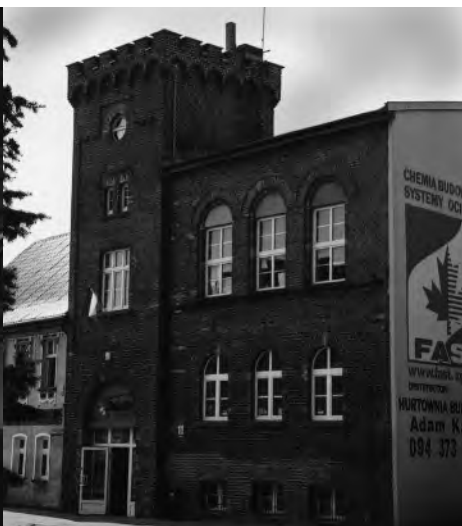
Bärwalde, ehemaliges Rathaus
