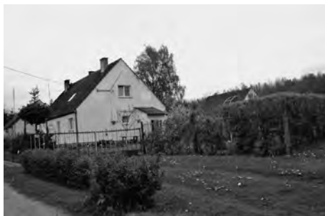
Bild 32: modernisierte ehemalige Arbeiterhäuser 2010
