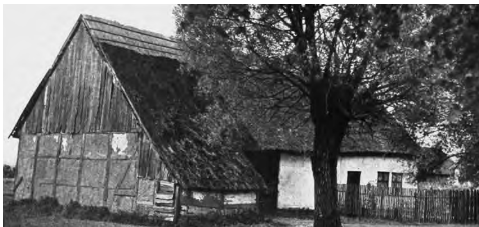
Bild 64: Friederizianisches Siedlungshaus in Auenfelde, 1938
