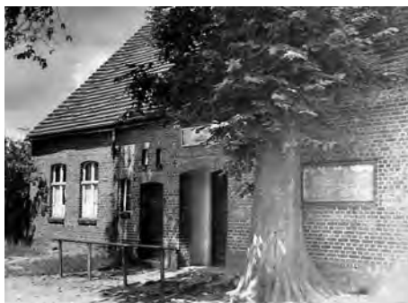
Bild 58: Schulgebäude 1968 - noch unverändert wie 1945
