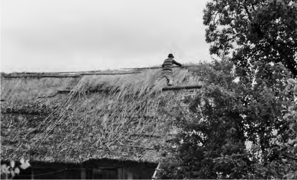
Bild 31: Eine alte Scheune in Wilhelmshorst wird mit Schilf ausgebessert, 2001
