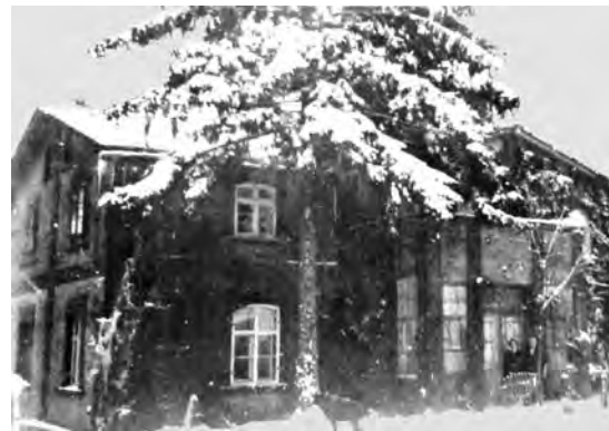
Bild 30: Wohnhaus, Zustand bis 1945
